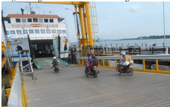
Gambar 1. Pelabuhan Penyebrangan Roro Bengkalis
