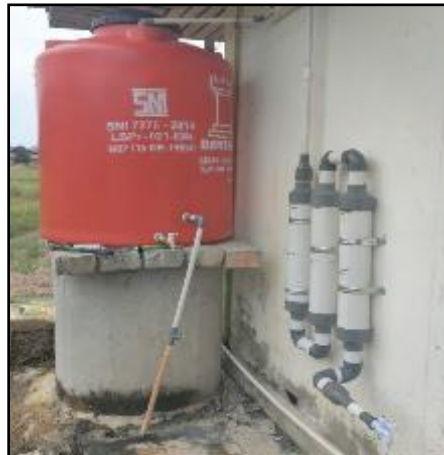
Gambar 4. Instalasi filterisasi Pipa bersusun Sumber : Penelitian, 2021
