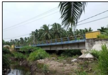
Gambar 1. Kondisi existing jembatan
