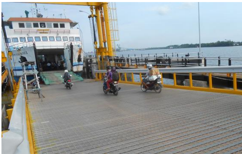
Gambar 2. Pelabuhan Penyebrangan Roro Bengkalis
