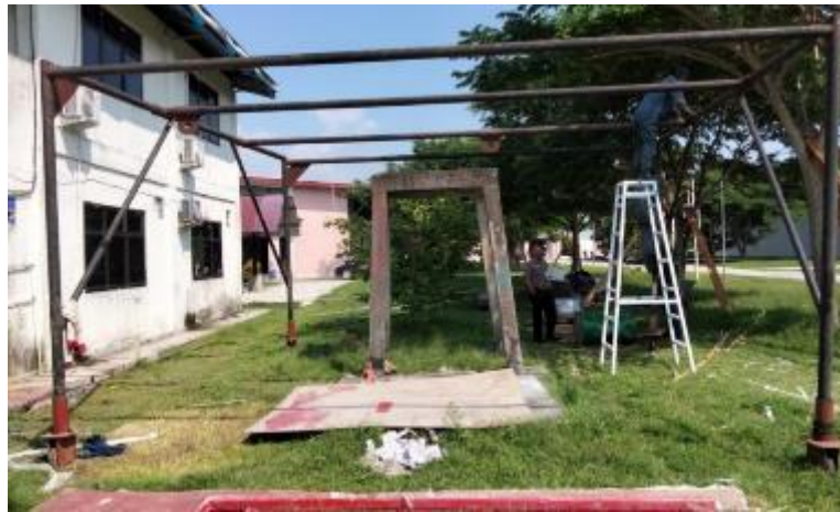
Gambar 2. Existing Crane Bengkel Galangan Mini
