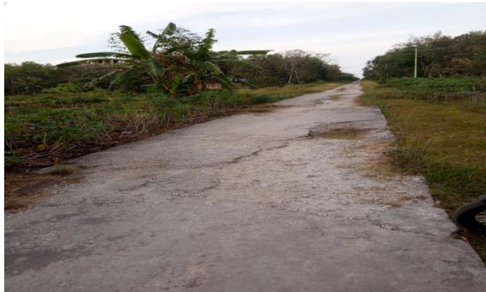
Gambar 5 Kondisi existing Jalan (STA 00+100)
