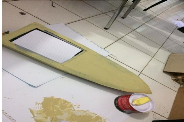
Gambar 5. Proses Pendempulan lambung kapal
