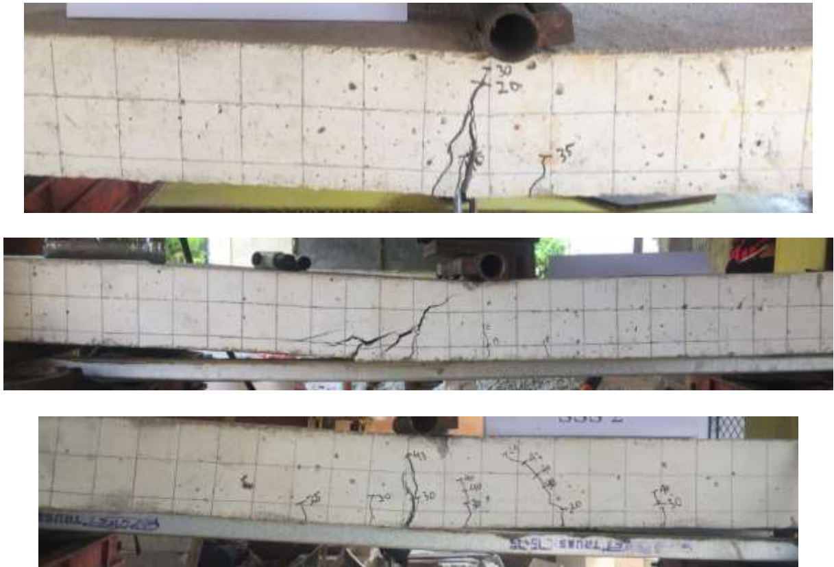
Gambar 7. Pola retak pelat PK, PPE-1 dan PPE-2
