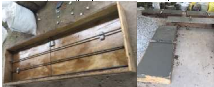
Gambar 2. Pembuatan pelat beton bertulang
